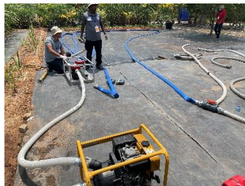
研修の中で浄水システムの設置と試運転を行う 研修生©IFRC
